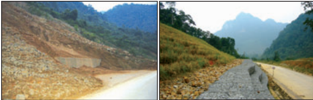
Foto 21: Da Deo Pass, Quang Binh: Esquerda: Cobertura vegetal é destruída, revelando falhas feias e contínuas de cortes nas encostas; direita: Linhas de Vetiver no topo da encosta espremem muito lentamente para baixo, reduzindo consideravelmente a massa que falhou.
