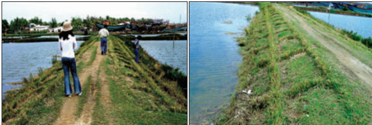
Foto 22: Barreiras de Vetiver, instaladas em uma comporta de cruzamento padrão, protegendo os diques de uma lagoa de camarão em Quang Ngai.
