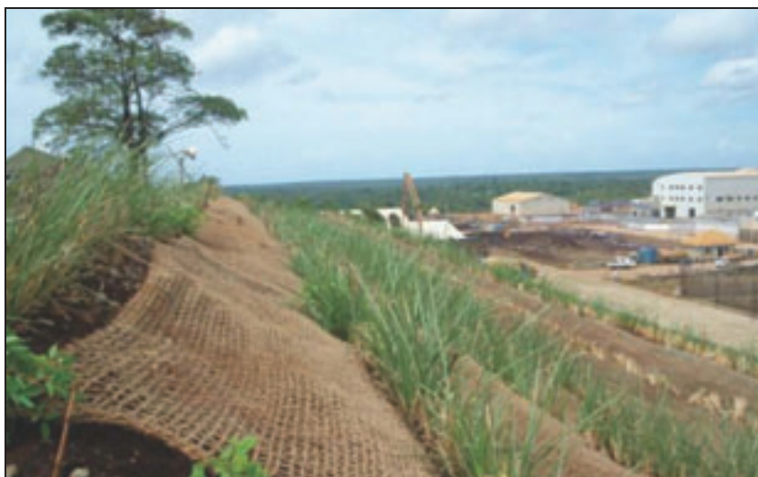
Foto 11: Mina de níquel no sul das Filipinas protegido por Gramas de Vetiver e esteiras (Biosolutions Inc).
