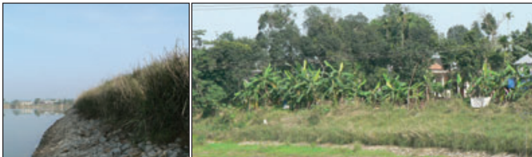
Foto 10: Esquerda: Vetiver e enrocamento de pedras (em cima) e com estrutura de concreto (em baixo) protegendo um declive em uma represa; direita: uma curva sobre plantações de Perfume nas bordas de um rio em Hue.
