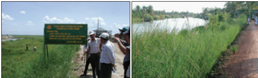
Foto 15: Em An Giang plantas de vetiver estabilizam um dique de rio (à esquerda), e a margem natural do rio (direita).
