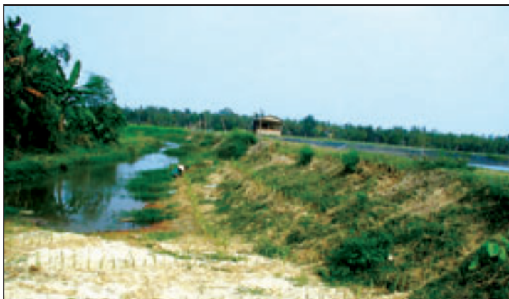
Foto 21: Barreiras de Vetiver protegendo uma lagoa de camarão próxima de um barranco natural que drena a água para dentro de um rio (na província de Da Nang), este modelo foi criado como parte do primeiro projeto de vetiver financiados pela Embaixada Real dos Países Baixos (Holanda) no Vietnã.
