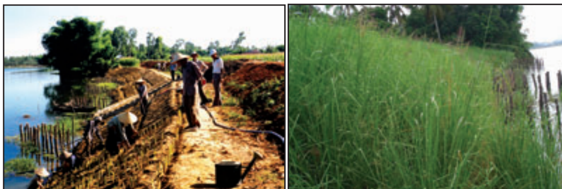
Foto 14: Esquerda: Membros da Comunidade plantando grama Vetiver; direita: Novembro de 2005: As margens do rio permanecem intactas após a época das cheias.
