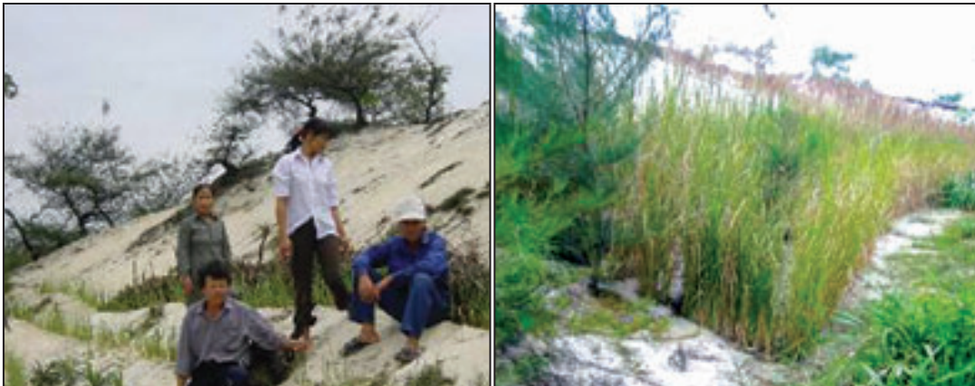
Foto 16: Início de Abril de 2002 - vetiver um mês após o plantio. Nota: A cobertura morta (composto de folhas vetiver) foi colocada acima da linha superior (à esquerda). Meados de Outubro de 2002 (sete meses): Casuarinas voltaram a restabeler-se entre as linhas de vetiver (direita)
