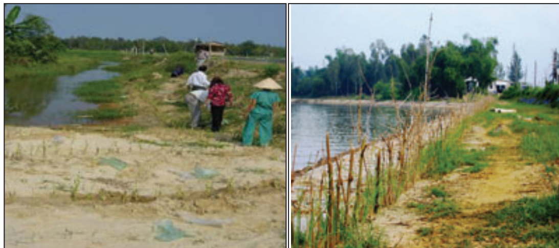
Foto 8: Esquerda: Março de 2002: SV executado à beira de uma lagoa de camarão, onde um canal drena águas das cheias de Vinh Dien River; direita: Novembro de 2002: o plantio em massa combinado com enrocamento de rochas para proteger as margens (bancos) ao longo do rio Vinh Dien.
